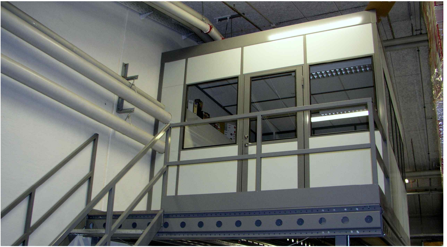
Kontor opført af Matadorvægge på mezzanin. Giver optimal pladsudnyttelse og overblik
